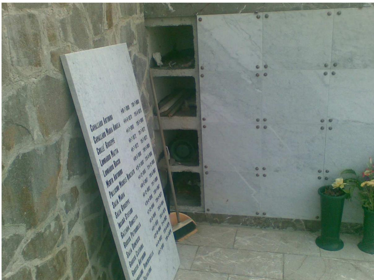
FOTO 1 – Le 4 lapidi laterali non sono collocate e la disposizione degli ossari è diversa dal progetto
